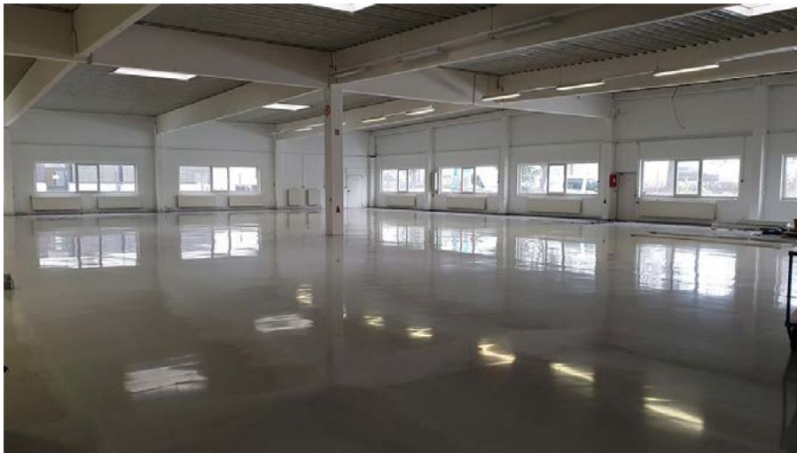
Derzeitiger Stand der Fertigungshalle der ATP Elektronik am neuen Standort in Norderstedt.
