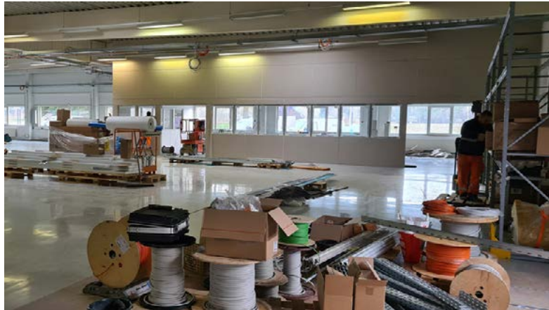
Viel Raum und Tageslicht: SMD-Fertigung der ATP Elektronik am neuen Standort in Norderstedt.
